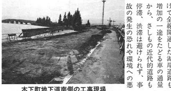
木下町地下道南側の工事現場
